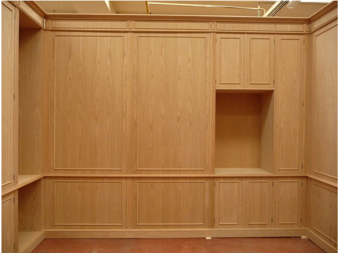
Boiserie grezza in fase di assemblaggio.
